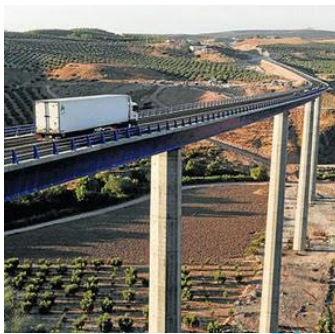
Viaducto en Granada
